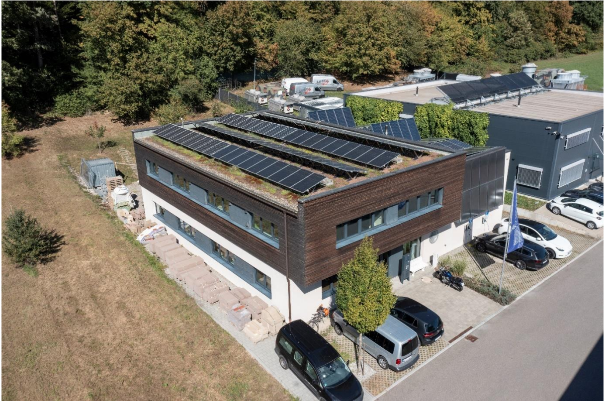
Abbildung 7: Naturnahe Lage des Büro- und Werkstattgebäudes in Ebersbach-Roßwälden (Quelle: AeDis AG)
